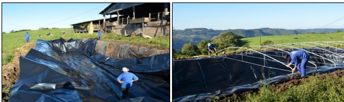
Figura 4. Construção de cisternas em propriedades de Carlos Barbosa.
