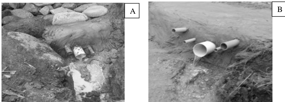
Figuras 1 A e B: Muro construído com rocha e solo cimento e colocação dos canos.
