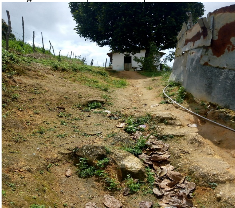
Figura 8. Solo exposto as intempéries e com ravinas
