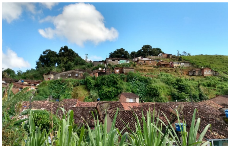
Figura 4. Vista parcial da área montante da encosta ocupada pela comunidade
