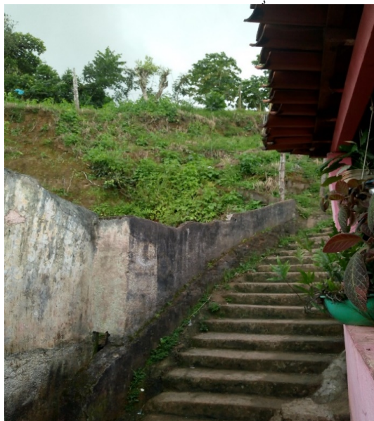
Figura 7. Vias de acesso interior e intervenção com o uso de escadarias
