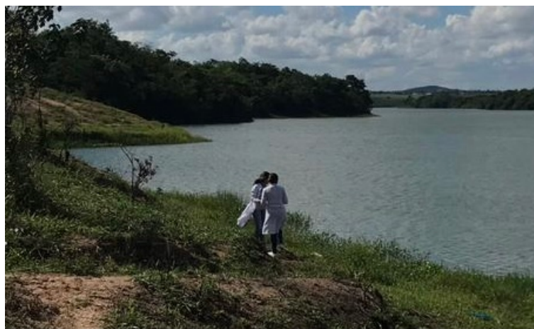
Figura 1. Barragem da Vila da Bananeira município de Arapiraca-AL.
