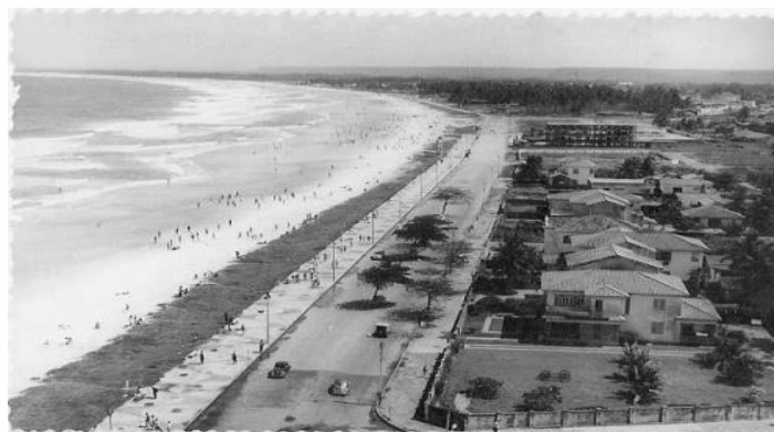
Figura 6- Praia da Avenida.
